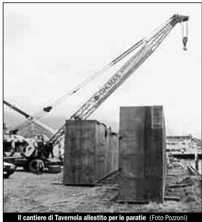
Il cantiere di Tavernola allestito per le paratie. (Foto Pozzoni)
